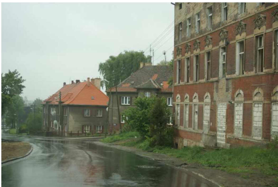
Fot. 6.1-28 Wyremontowany odcinek ul. Nad Odrą (skrzyżowanie z ul. Leśną). Proponuje się ograniczenie prędkości pojazdów.
