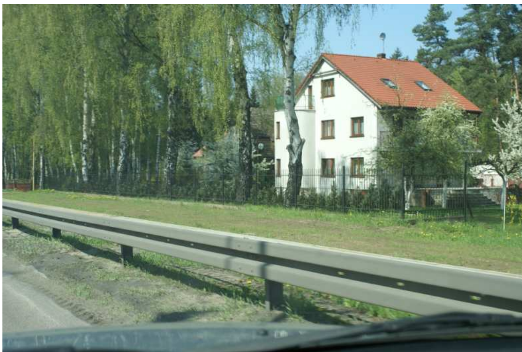
Fot. 6.1-6 W obszarze działania D3 zabudowa mieszkaniowa znajduje się w znacznej odległości od pasa drogowego, jest zabudową nie wysoką co stwarza bardzo dogodne warunki dla realizacji skutecznego ekranu akustycznego.
