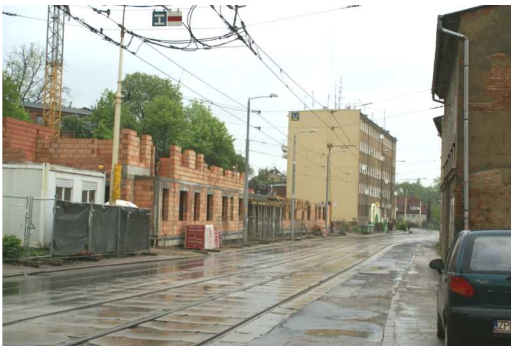
Fot. 6.1-33 W obszarze D31 zabudowa mieszkaniowa wielorodzinna znajduje się w bezpośrednim sąsiedztwie pasa drogowego. Realizowane są kolejne inwestycje budowlane.
