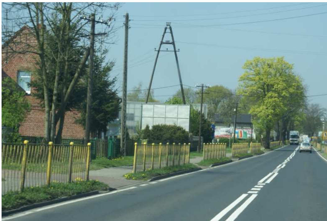
Fot. 6.1-3 Na przeważającej długości odcinka drogi w obszarze działania D1 znajduje się duża liczba włączeń do drogi głównej. Uniemożliwia to zaprojektowane skutecznego ekranu akustycznego.
