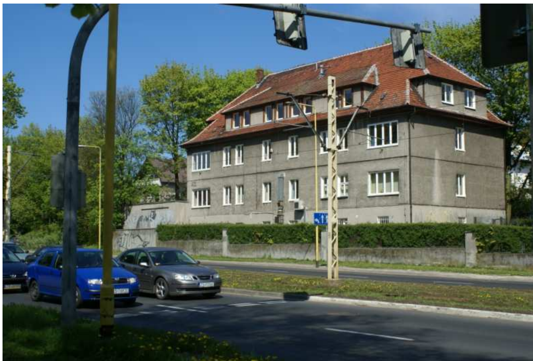
Fot. 6.1-55 Budynek mieszkalny w obszarze działania D76, w sąsiedztwie z skrzyżowaniem z ul. Ostrawicką
