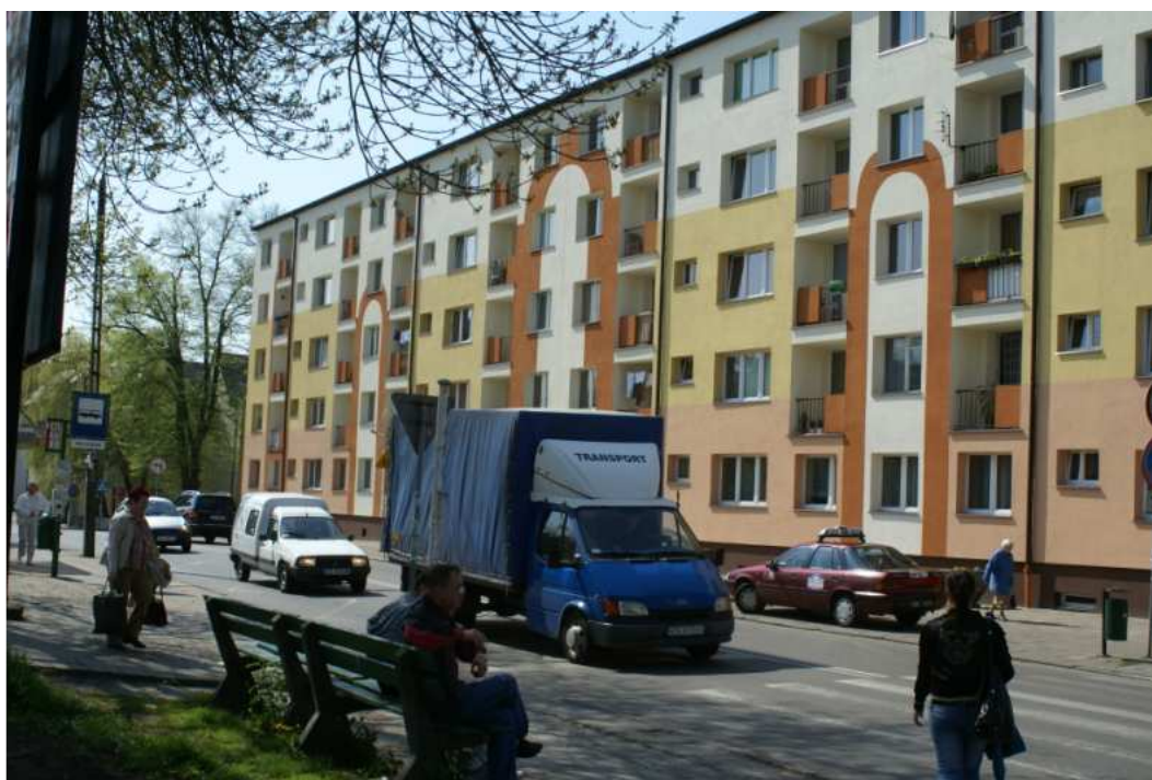
Fot. 6.1-25 Zabudowa wielorodzinna 5-kondygnacyjna przy ulicy Krzywoń (Dąbie) znajduje się w odległości 3-4m od krawędzi jezdni.
