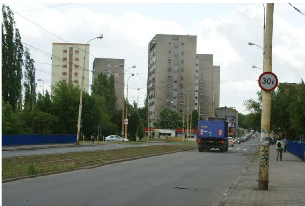
Fot. 6.1-41 Budynki przy ul. Budziszynskiej 6, 8 i 10 znajdują się w małej odległości od jezdni, a ze względu na swoją wysokość, ich ochrona poprzez realizację ekranów akustycznych jest praktycznie niemożliwa.
