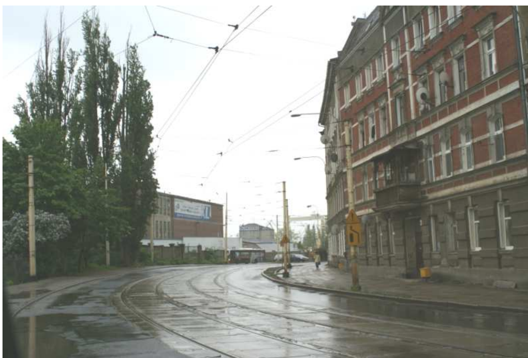
Fot. 6.1-36 Zabudowa wielorodzinna 5 kondygnacyjna przy narażona na hałas potęgowany przez bardzo zły stan nawierzchni drogowej, oraz zły stan linii tramwajowej
