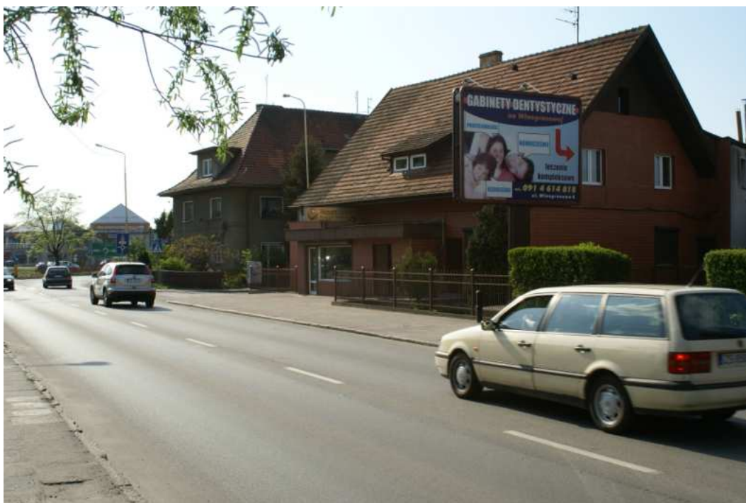
Fot. 6.1-13 W południowej części obszary D8 znajduje się zabudowa mieszkaniowa jednorodzinna, która ze względu na bliskość pasa drogowego nie może być chroniona ekranem akustycznym
