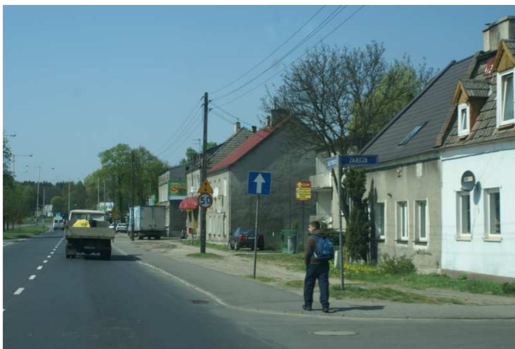
Fot. 6.1-8 W obszarze D4 proponuje się realizację ekranu akustycznego po północnej stronie jezdni. Znaczna odległość pomiędzy zabudową a jezdnią, oraz częste postoje pojazdów czynią to rozwiązanie najbardziej racjonalnym w tym miejscu.
