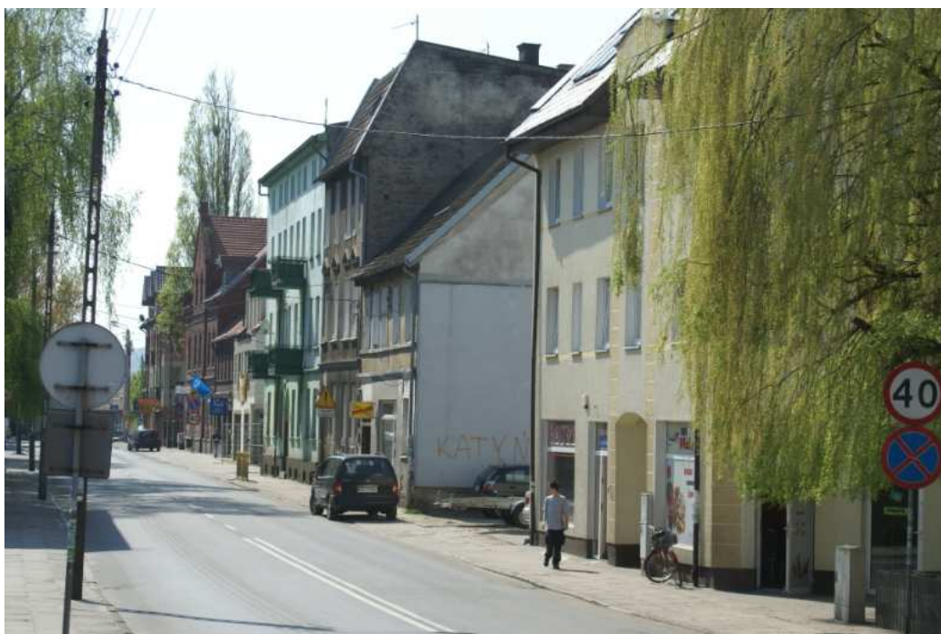
Fot. 6.1-26 Ulica Krzywoń (3-4 kondygnacyjna) znajduje się w odległości 2-3m od krawędzi jezdni.
