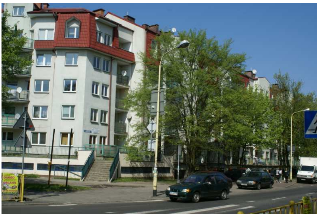
Fot. 6.1-22 Budynek mieszkalny wielorodzinny, 5-kondygnacyjny przy ulicy Goleńkowskiej 112
