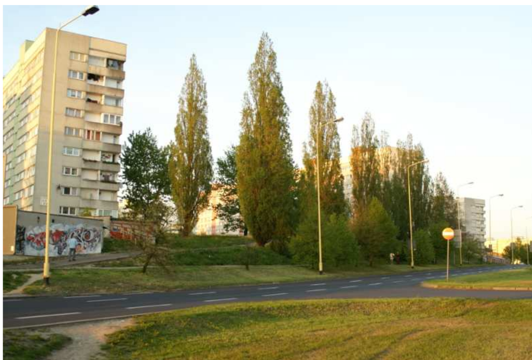
Fot. 6.1-49 Cztery budynki mieszkalne wielokondygnacyjne przy ul. Kaliny i Derdowskiego – obszar działania D70.
